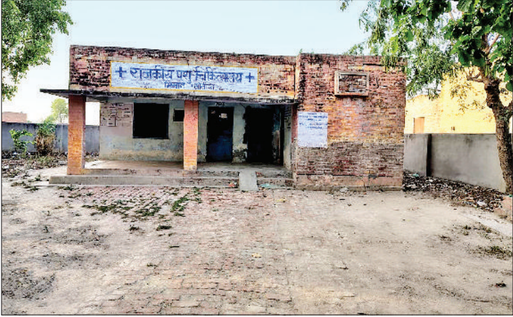
सोनीपत। गांव भिगान में राजकीय पशु अस्पताल का पुराना भवन।
